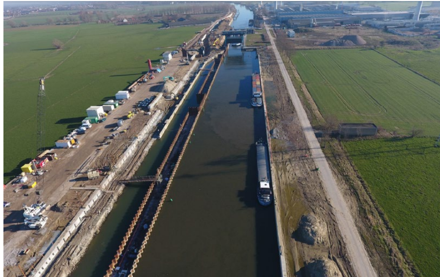
Campagne de mesure chantier écluse Sint-Baafs-Vijve
