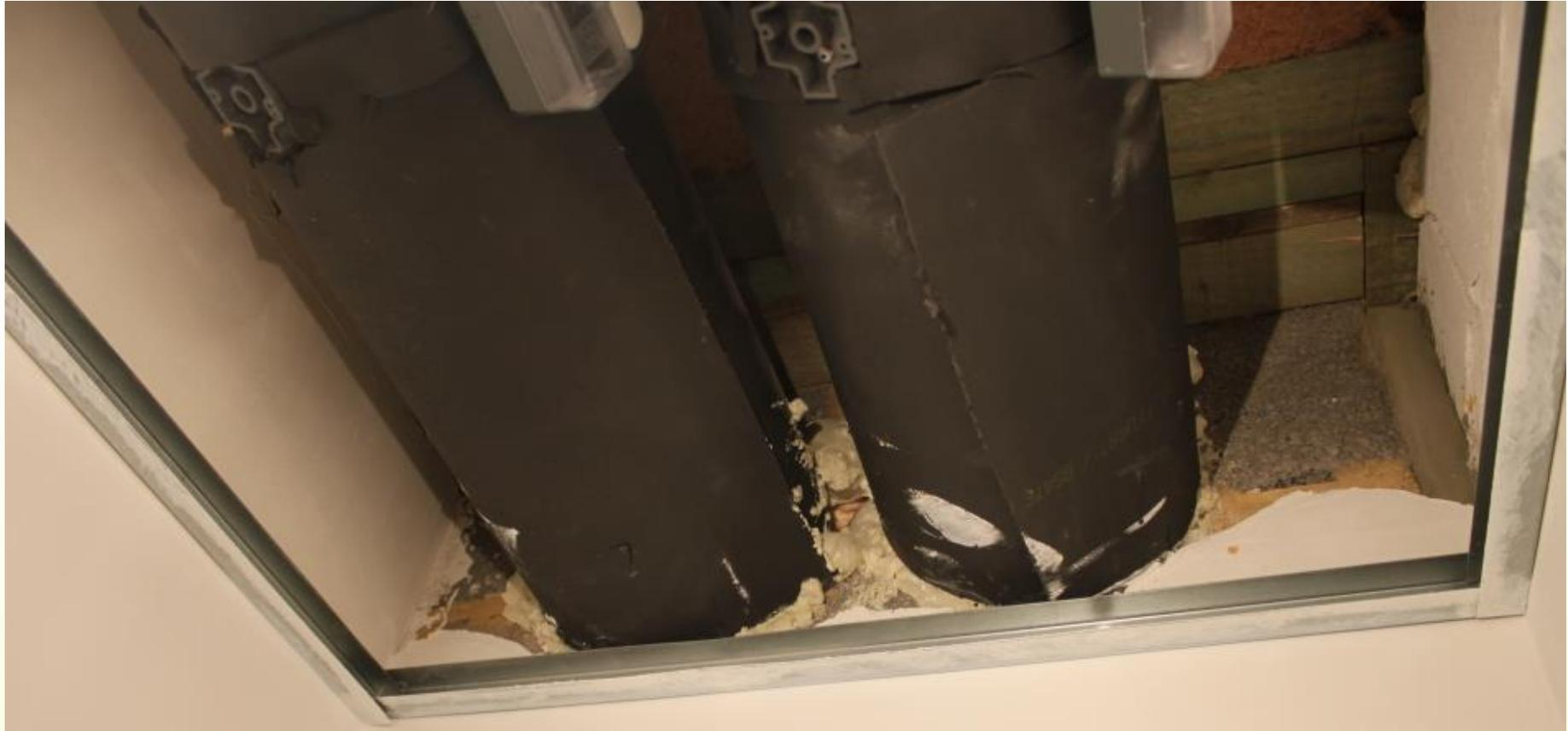
**Les tuyaux du système de ventilation pénètrent dans la gaine technique, le resserrage est réalisé au moyen de mousse expansive.**
