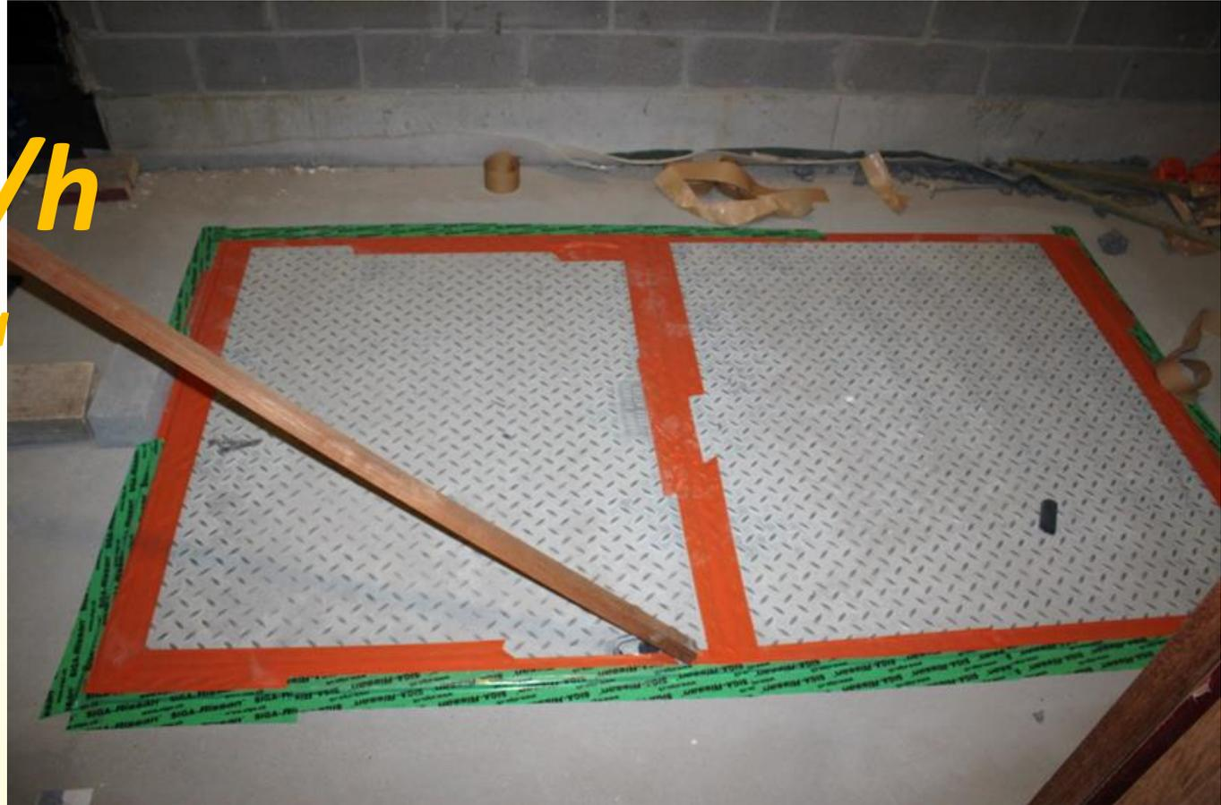
**Les panneaux d'accès à la cabine haute tension sont responsables d'un passage d'air d'environ 560 m<sup>3</sup>/h (50 Pa).**
