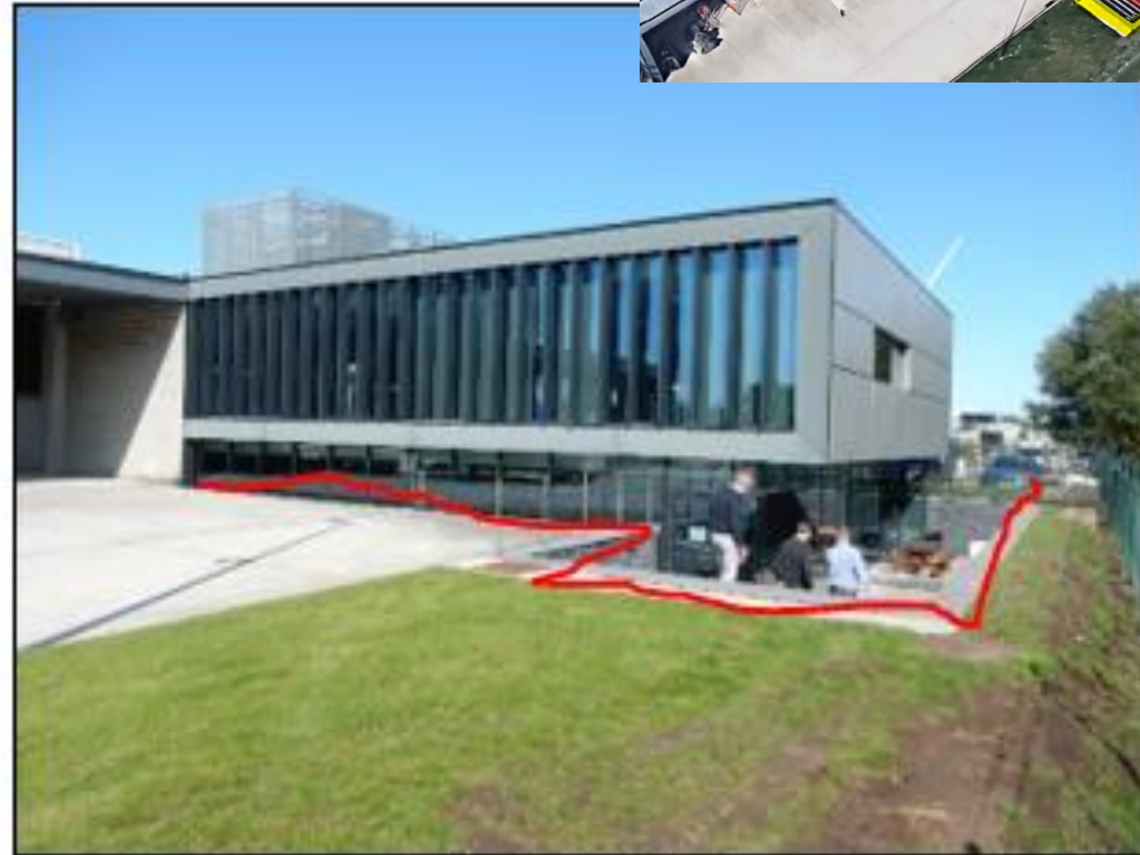
Achtergevel (W) (verdiepingen -0,5 en +0,5)
