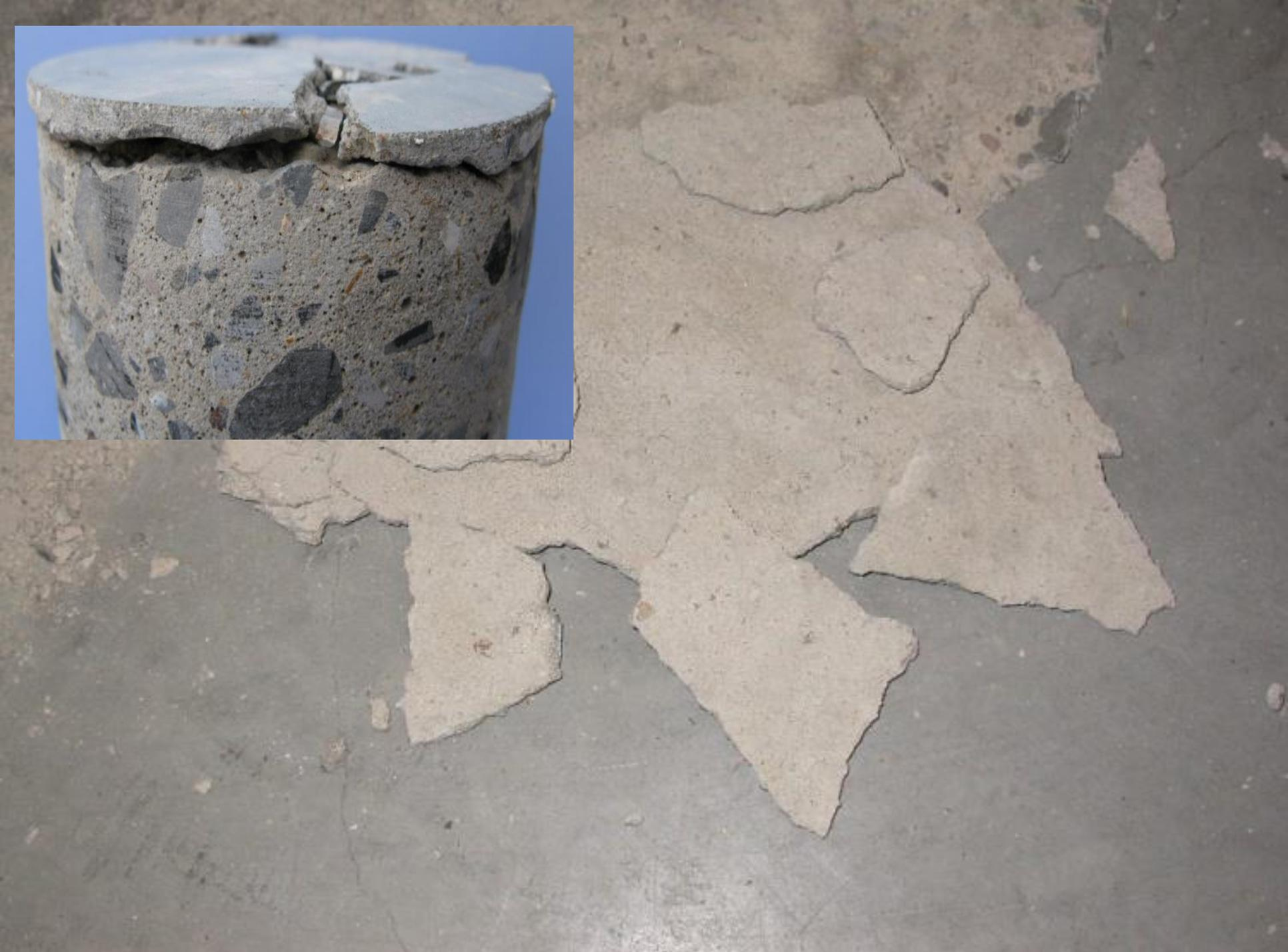
**Eau de ressuage** ou **bulles d'air** sous une surface fermée polie
